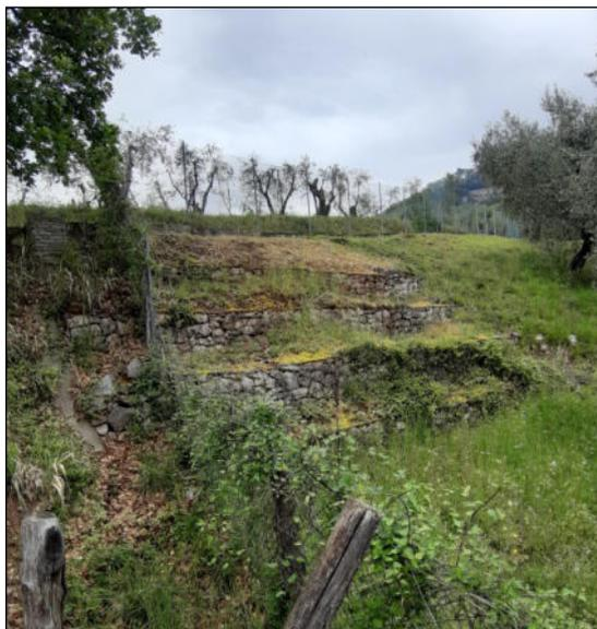
3) Fra ottobre e dicembre del 2019, a seguito di eventi piovosi intensi, si sono verificate delle deformazioni e dei crolli dei muri a secco a monte della sede stradale lungo Via Bronzuoli, in località Montevettolini. Questo ha comportato la chiusura della viabilità e la realizzazione di opere di contenimento temporanee. Le immagini inserite di seguito riportano l'ubicazione e lo stato attuale delle tre aree in cui sono avvenuti i crolli dei muri.
