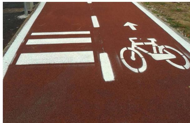
Nel caso invece dei tratti ad uso promiscuo, sempre con colorazione in pasta del manto di usura, è previsto il solo tracciamento delle strisce di margine e, ad integrazione dei segnali verticali, quello dei simboli a terra del "velocipede" accoppiato al "pedone", come dall'esempio tipologico successivamente riportato.
