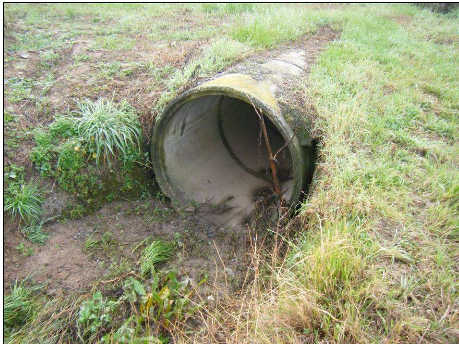
Figura 18 – Tubazione  $\varnothing$  110 cm con cui il Fosso Arrù sottopassa Via del Terzo (vista verso valle)
