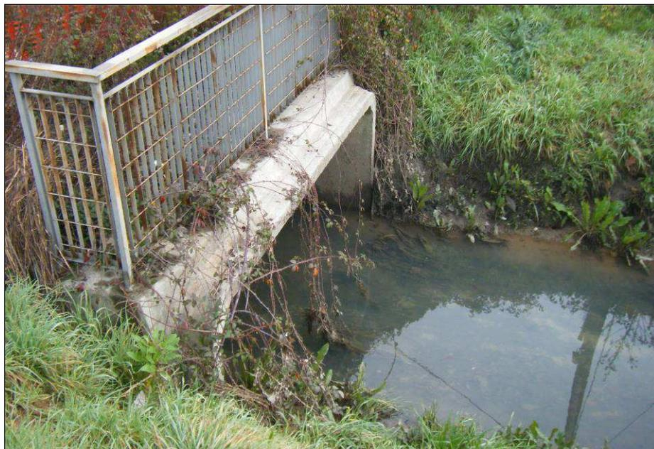
*Figura 43 - Scatolare 3.0 x 1.25 m con cui il Rio Pratovecchio sottopassa la S.p. del Terzo*
