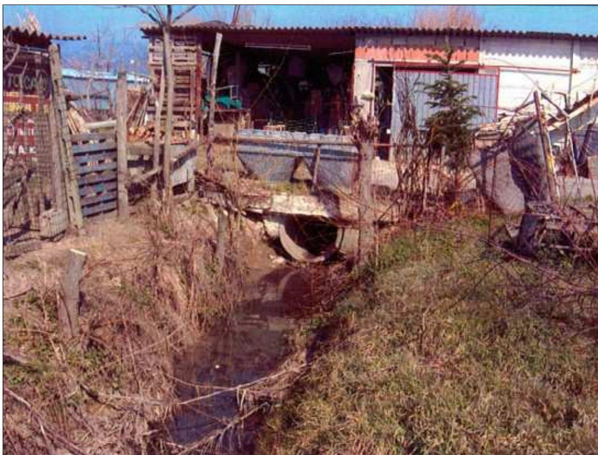
*Figura 16 –Passaggio del Fosso Arrù sotto la rimessa agricola presente con Ø 60 cm*
