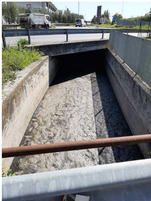
Figura 28 – Presenza di sedimenti in corrispondenza della stazione di sollevamento delle acque nere che lasciano presagire la presenza di scolmatori della rete o scarichi diretti
