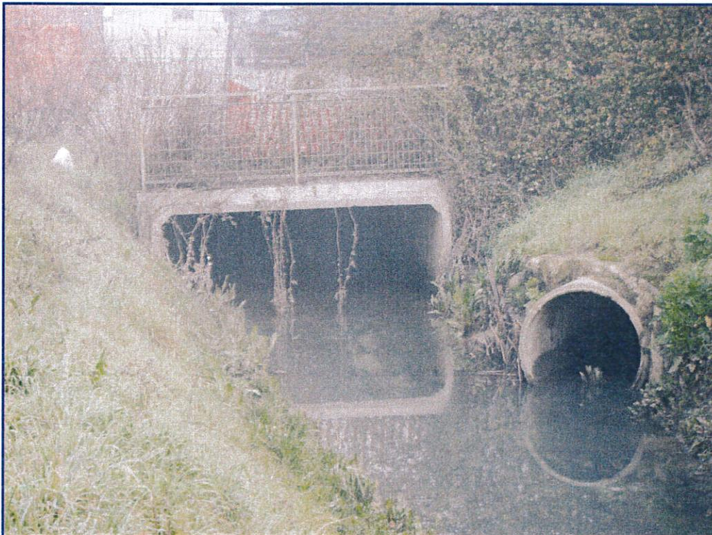
Figura 12 - Sottopasso del Rio Pratovecchio con la S.P. del Terzo (scotalare 3.0 x h 1.25 m)
