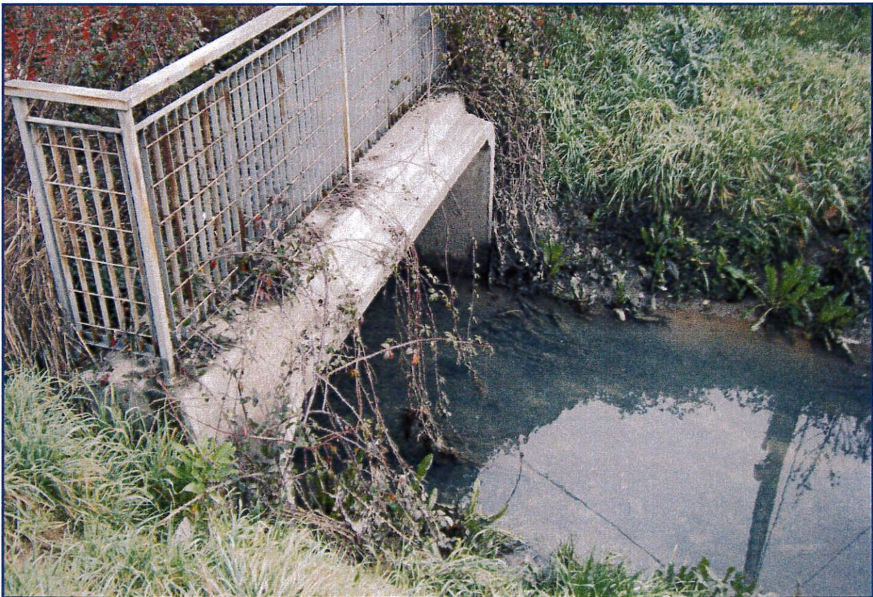
*Figura 27 - Scatolare 3.0 x 1.25 m con cui il Rio Pratovecchio sottopassa la S.p. del Terzo*
