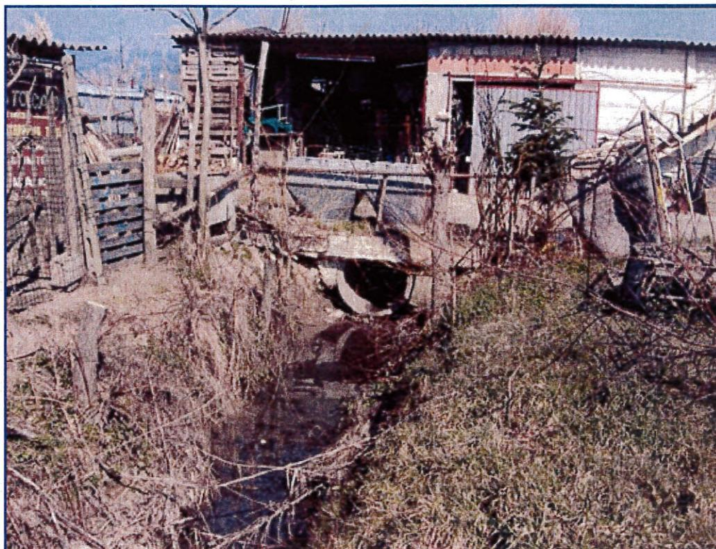
*Figura 7 –Passaggio del Fosso Arrù sotto la rimessa agricola presente con Ø 80 cm*
