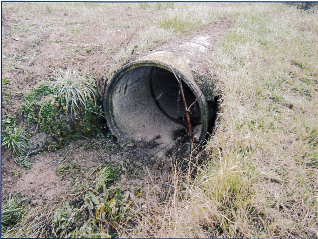
**Figura 8 – Tubazione Ø 110 cm con cui il Fosso Arrù sottopassa Via del Terzo (vista verso valle)**
