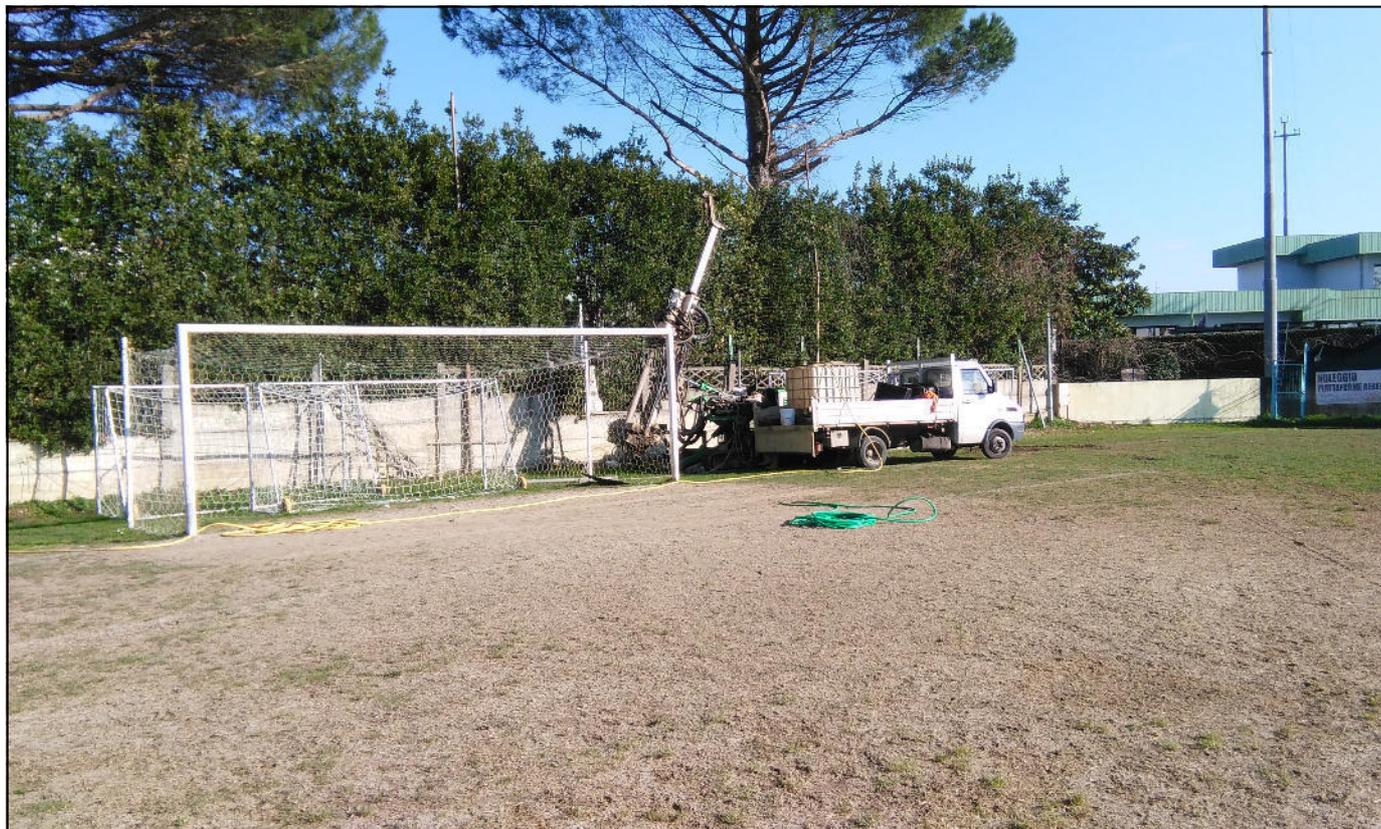
**Da 0m a -5m** da -2m a -2,5m Campione Indisturbato S1C1. A -4m Campione Disturbato S1C2
